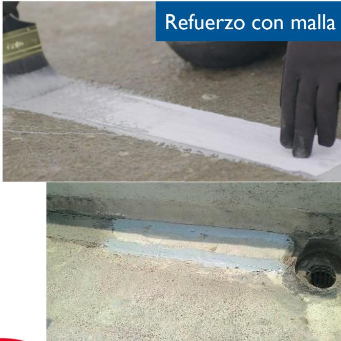
Para las juntas de mucho movimiento como bajantes de agua, juntas frías, unión de rampas chaflanes, entre otras, se debe sellar con **Fester Superseal P** y un refuerzo con una capa de **FesterSIP I 620 FT** o **FesterSIP I 620 MC** según corresponda, asentando simultáneamente lienzos de **Malla Fester Revoflex** que excedan en 10 cm el punto crítico tratado.
